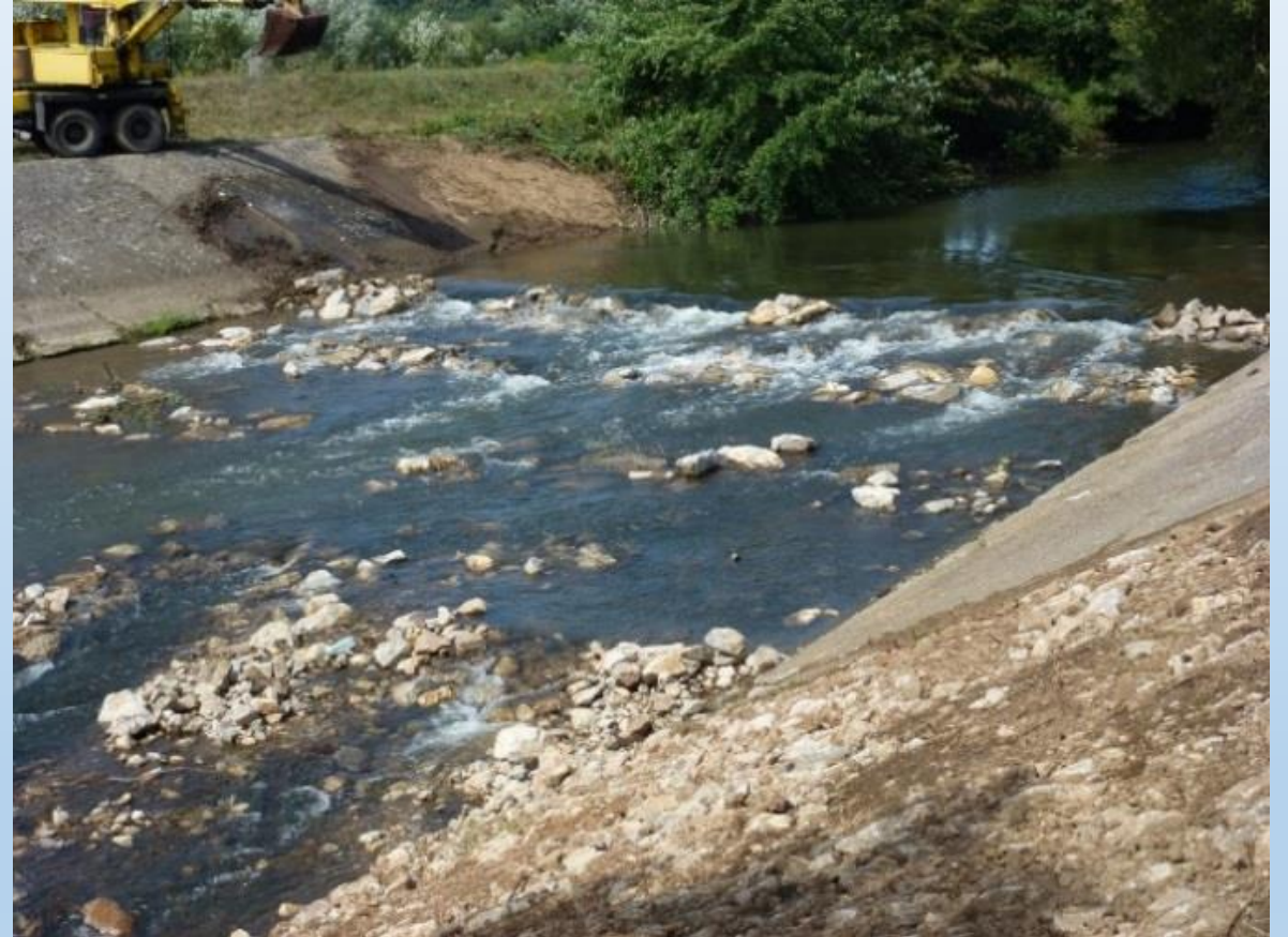
revitalizovaný stupeň – celokorytový bystrinný sklz
