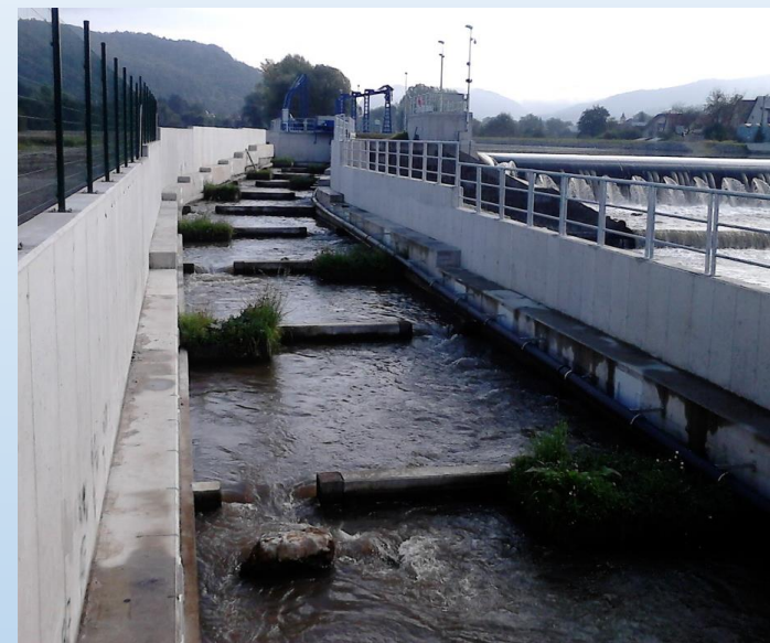
pravostranný obtokový prepážkový rybovod pri hati
